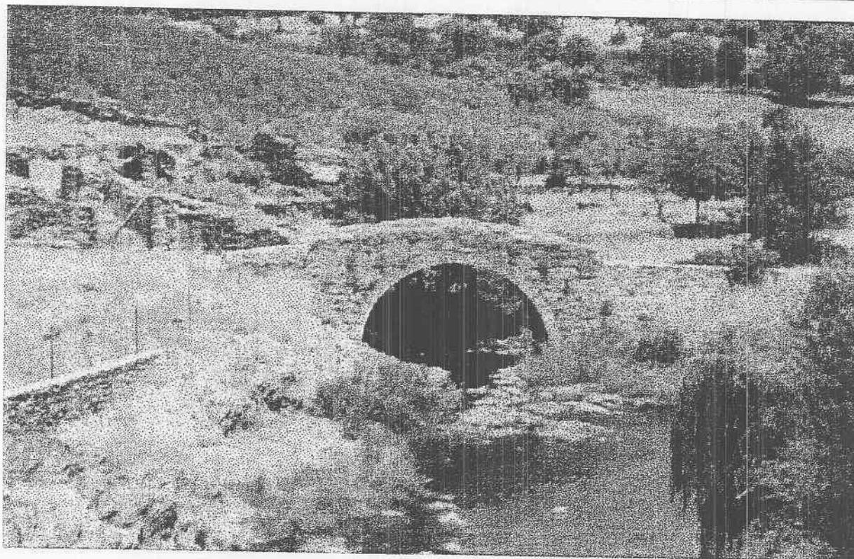
**OBSERVACIONES:** Hermoso ejemplar de obra civil sobre el cauce del río Ambroz, en el que destaca su único arco de sillería de granito.
